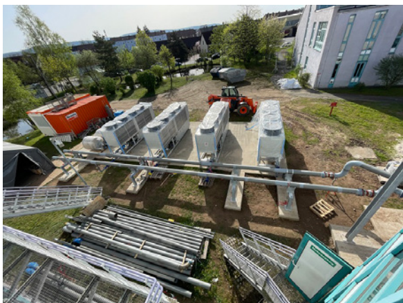
05 – Verrohrung Wärmepumpen
