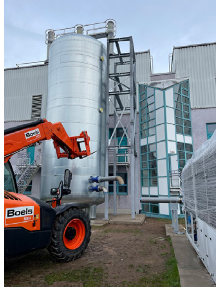
02 – Stahlbau für Rohrinstallation Pufferspeicher
