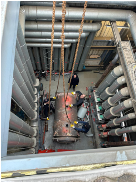
03 – Ausbringen alter Heizkessel über das Dach (Heizzentrale)
